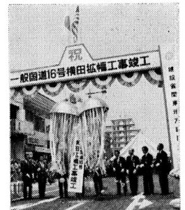
▲ 5月6日 国道16号 拡幅工事完成
