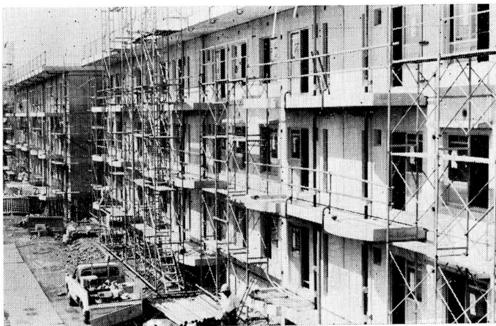
▲ 建設中の市営住宅
