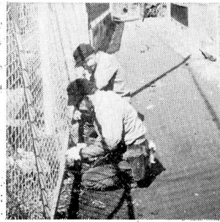
▲フェンス作り
