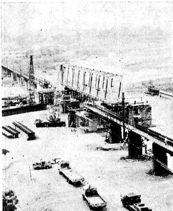
▲1日ばかりで新しい鉄橋に架け替え
