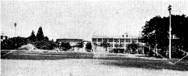
▲第一中学校散水器
