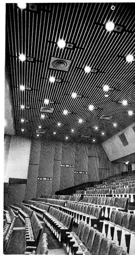
▲大ホールの天井と側面はパイプ仕上げ。
