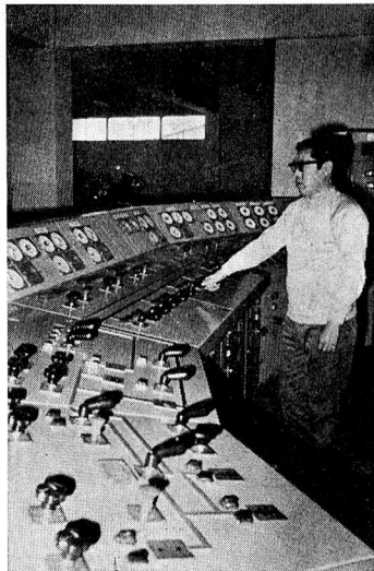
第3浄水場に配水施設を増設
