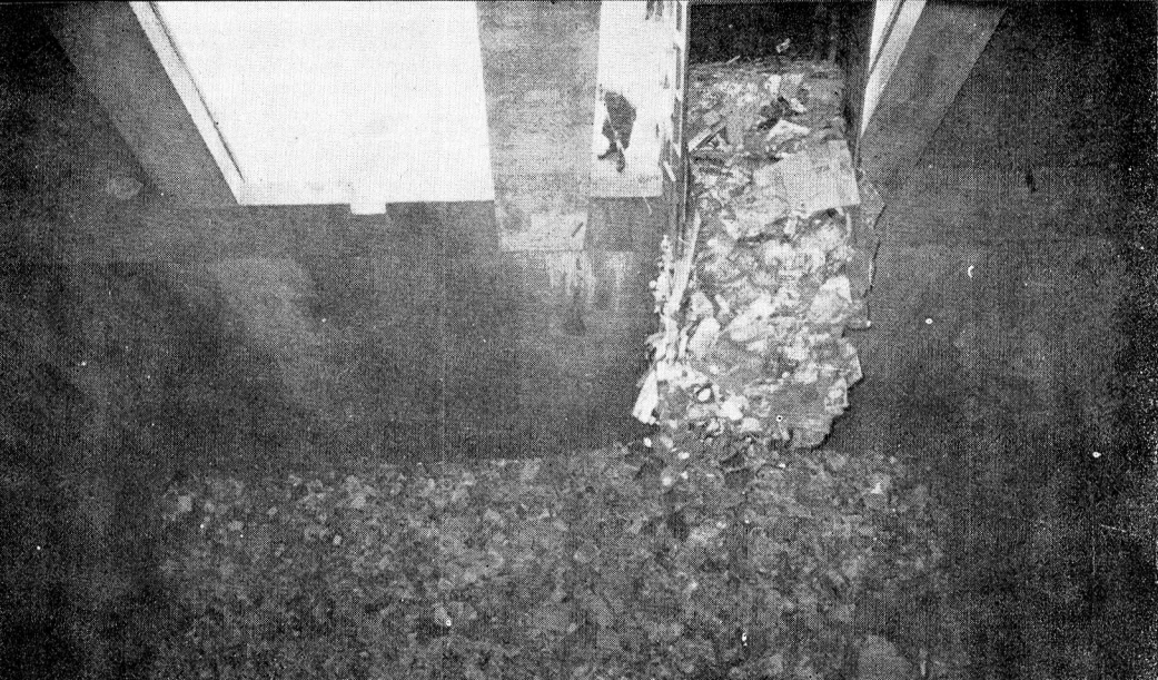
300トンのじん芥をのみこむじん芥濠、旧処理場の3倍（深さ10m、横15m、縦6m）
