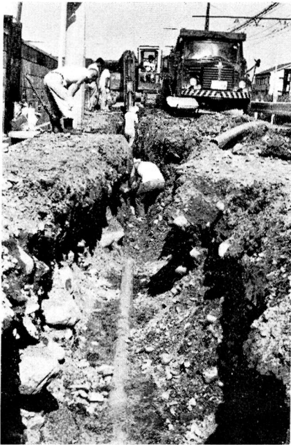
配水管埋設工事
