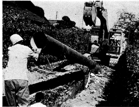
配水管埋設工事
