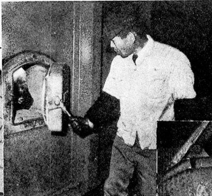
▲じん芥は重油で 1000度に熱せられ た焼却炉の中で焼 かれる
