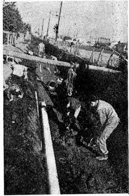
4850mの配水管を埋設
