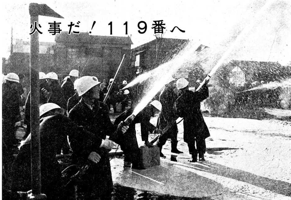
(写真は、油火災に対する泡沫液の放水)
