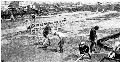
7月完成をめざし進められた町民プール工事
