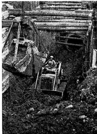
昭和40年度から昭和41年度に繰越された横田基地周辺排水工事
