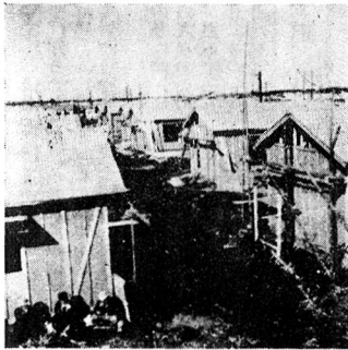
(工事中の町営住宅)
