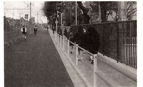
△第一中学校西青梅線側道に歩道を設置。安心して通れるようになりました。
