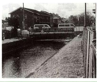
かつては、熊川村村有の「作場橋(農作業等で通行するための橋)」で素朴な木橋でした。以後、改修を重ね、昭和37年3月の架替前までは、橋長10m、幅員2.7mでした。その後、さらに橋長16.5m、幅員6mに拡張されました。しかし、接続する道路は、約7mの幅員が
