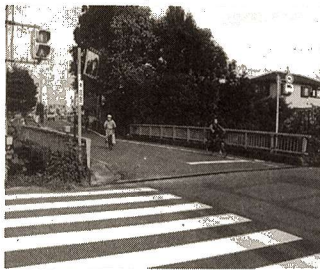
橋長=15・64m 幅員=6・60m 竣工=昭和51年
