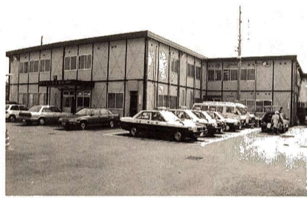
▲福生警察署仮庁舎(福生2131-1)
