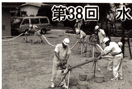
明神下公園に設置された応急給水槽の給水
