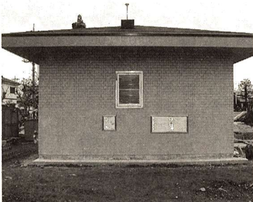
▲完成間近の応急給水槽上屋
