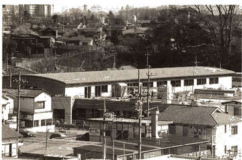
建設が進む福祉センター(仮称)
