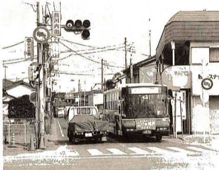
交通量の多い陸橋通り
