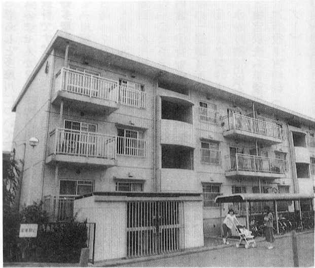
▲ 第三市営住宅
