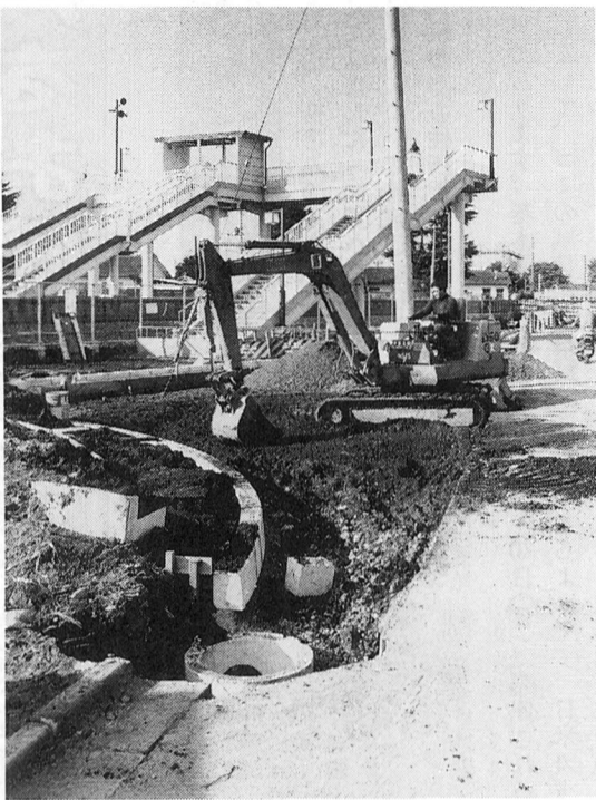
自由通路も完成し整備が進む東福生駅
