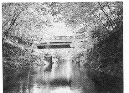
▲玉川上水の新堀橋付近
