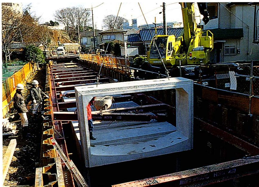
着々と進められている雨水排水工事
