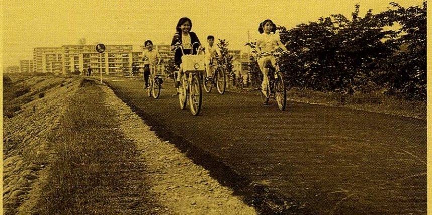
五日市線から南公園手前までの自転車道完成(昭和50年)
