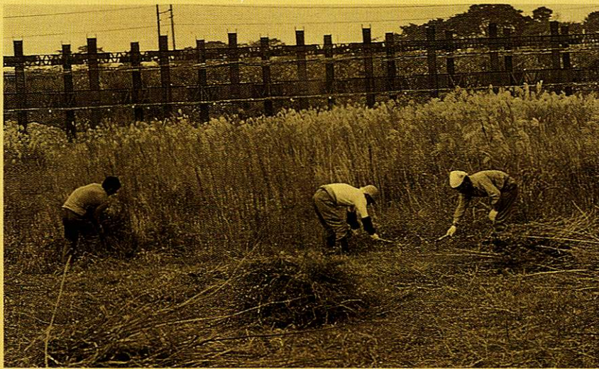
福生団地建設始まる(昭和47年)
