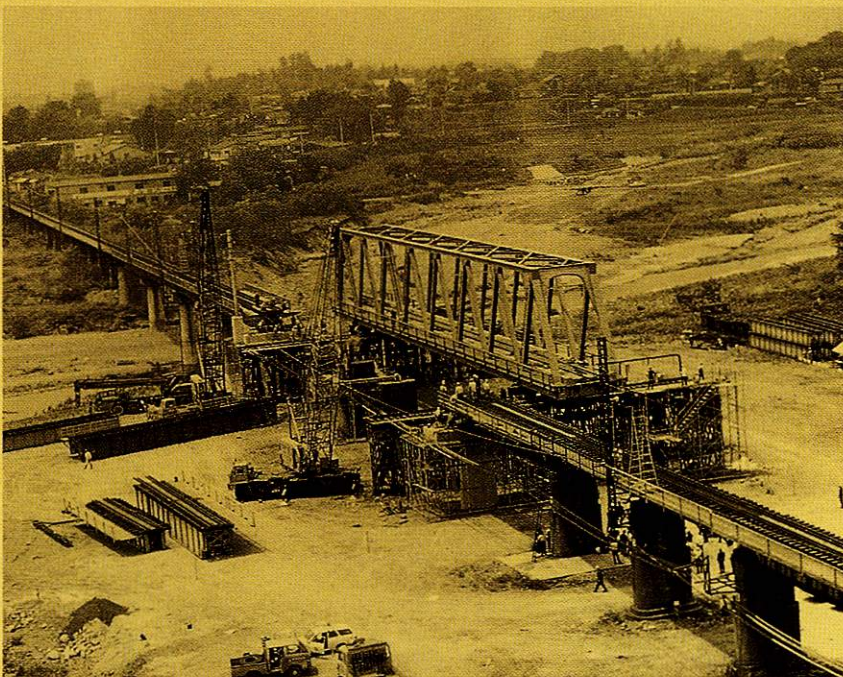
五日市線多摩川鉄橋53年ぶりに橋げた交換(昭和53年)
