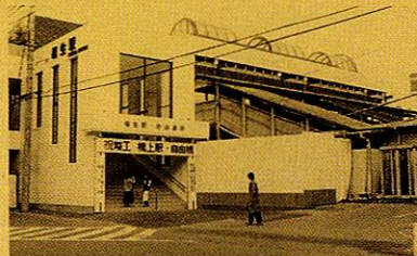
福生駅橋上駅舎、自由橋完成(昭和61年)
