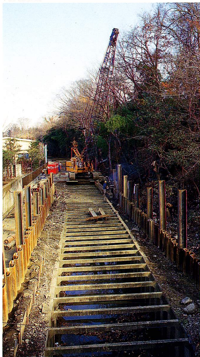
下の川改修工事
