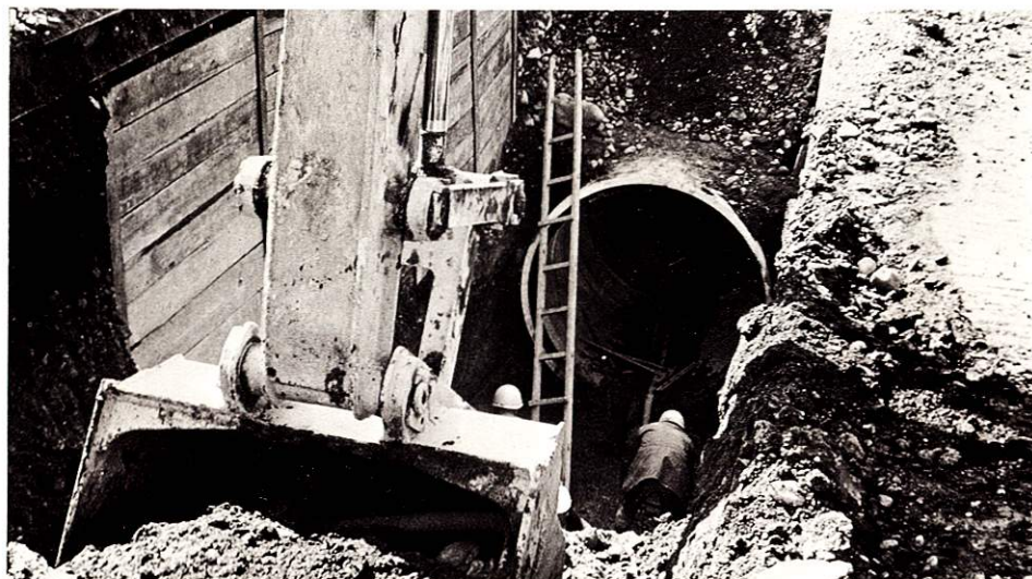
排水管理設工事
